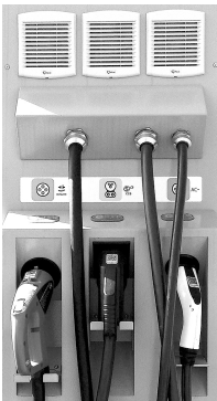
Bild 7 Lademöglichkeiten von Elektrofahrzeugen und "Fahrzeugkupplung einer Combo-2-Schnellladestation"
